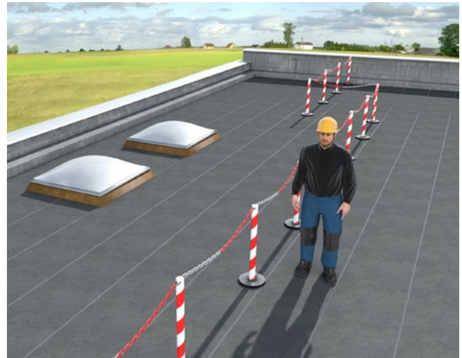
Abb. 56 Arbeiten außerhalb des Gefahrenbereiches mit Sicherung des Gefahrenbereiches z. B. durch Kette oder Begehen eines Verkehrsweges außerhalb des Gefahrenbereiches mit Kennzeichnung
