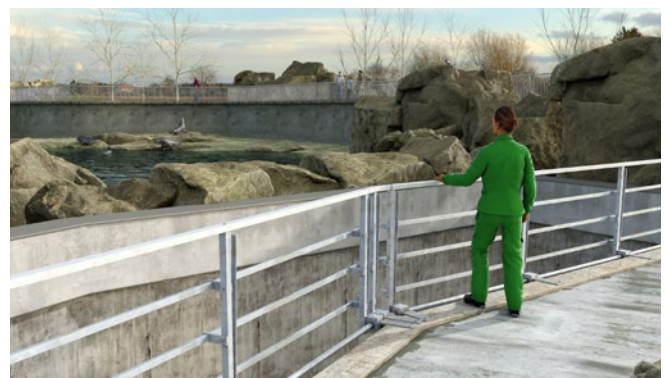
Abb. 58 Verfahrbare Umwahrung (ausgefahren), wenn der Verkehrsweg genutzt wird
