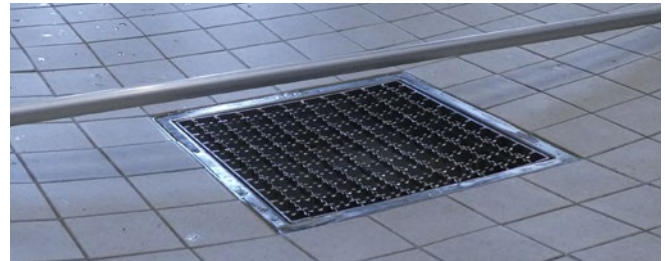
Abb. 37 Rutschfeste Ablauföffnung mit ausreichendem Gefälle
