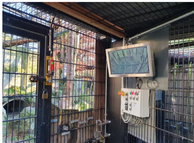
Abb. 15 Verriegelung einer Gehegetür durch eine Sicherheits-SPS
