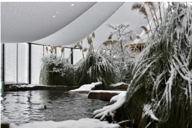
Abb. 68 Unter der Schneelast nachgegebene Gehegeeinfriedung in einem Tropenhaus
