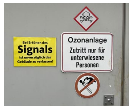
Abb. 44 Zugang zu einer Ozonanlage
