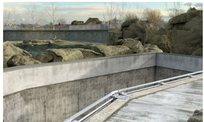
Abb. 57 Verfahrbare Umwahrung (eingefahren)
