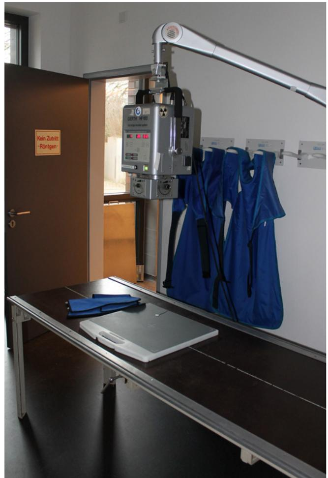
Abb. 30 Stationäres Röntengerät mit Schutzkleidung
