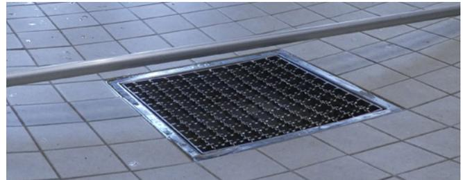
Abb. 37 Rutschfeste Ablauföffnung mit ausreichendem Gefälle
