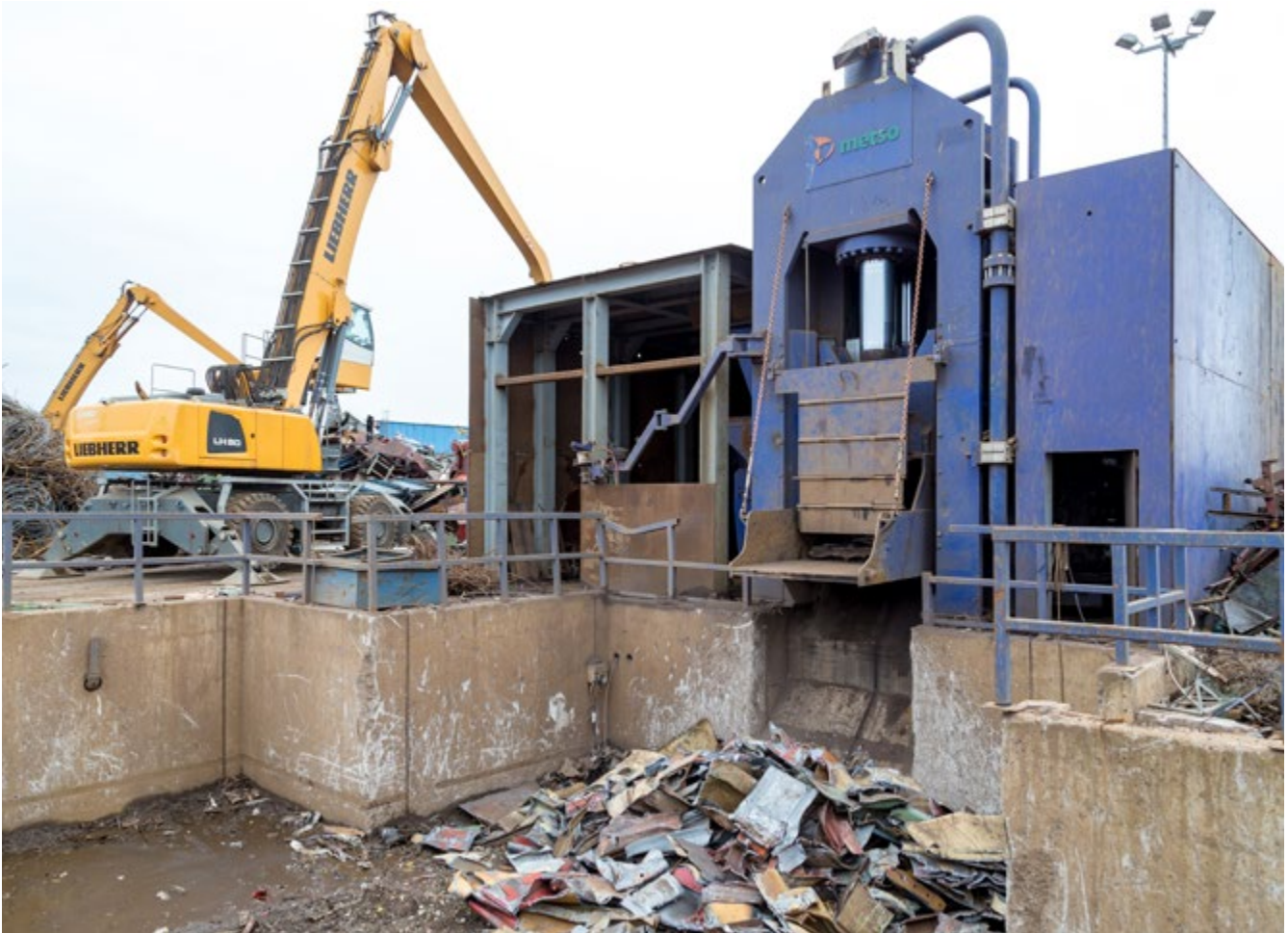
Abb. 74 Mit Prallplattenvorhang versehener Auslauf einer Guillotineschere verhindert das Wegfliegen von Schneidgut
