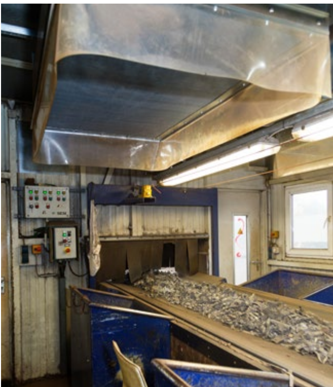
Abb. 47 Gut ausgeleuchtete Arbeitsplätze in einer Sortierkabine, oben ist die Zufuhr von Frischluft zu sehen
