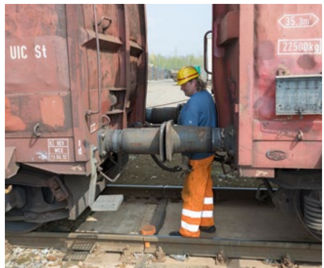
Abb. 15 Kuppel- und Entkuppelarbeiten im „Berner Raum“
