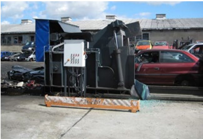
Abb. 92 Frei zugänglicher Steuerplatz für das Bedienpersonal
