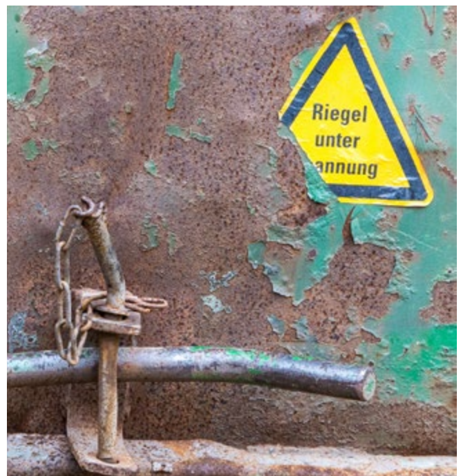
Abb. 10 Schild weist auf möglichen Öffnungsdruck hin
