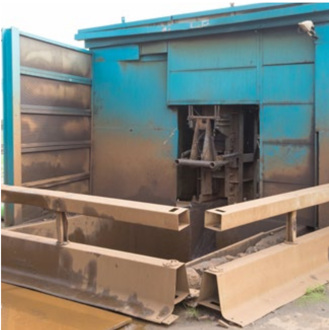
Abb. 51 Absturzsicherung an Grube eines Schienenbrechers
