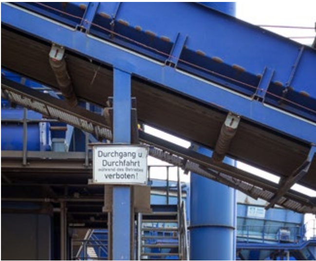
Abb. 69 Zugangsverbot während des Betriebes
