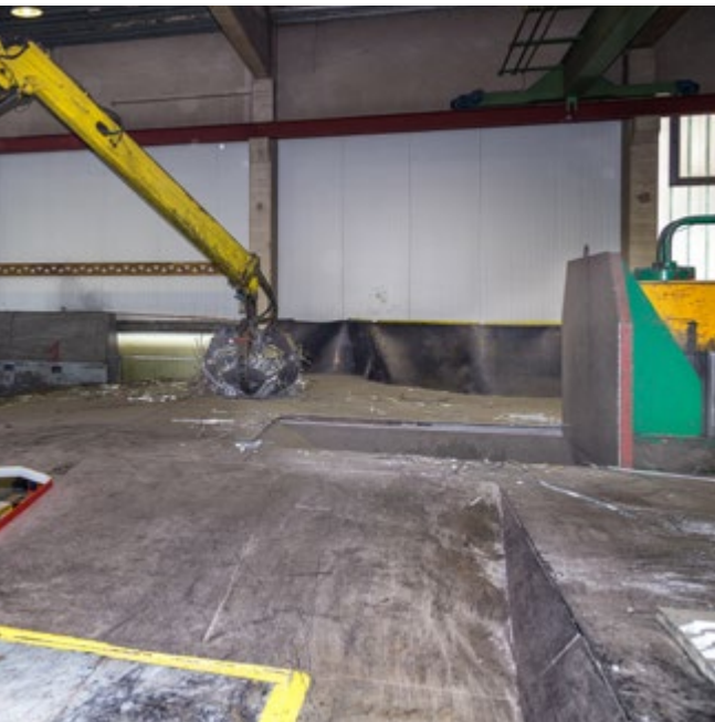
Abb. 60 Gute Sicht auf die Gefahrstellen am Pressenschacht
