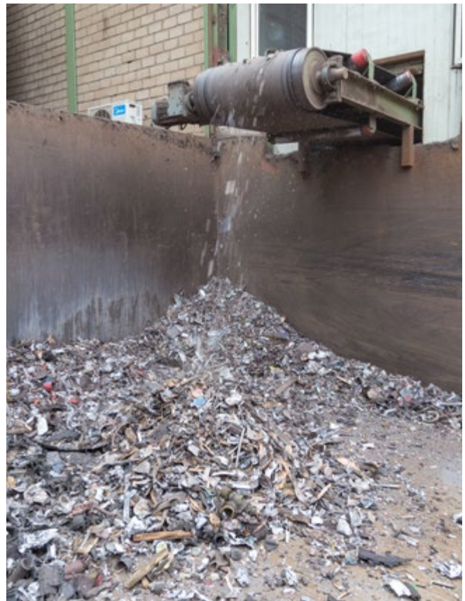
Abb. 44 Trennwände im Abwurfbereich
