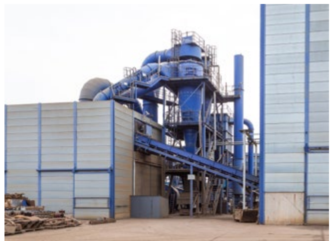
Abb. 66 Einhausung mit schallabsorbierendem Material als Lärmschutz
