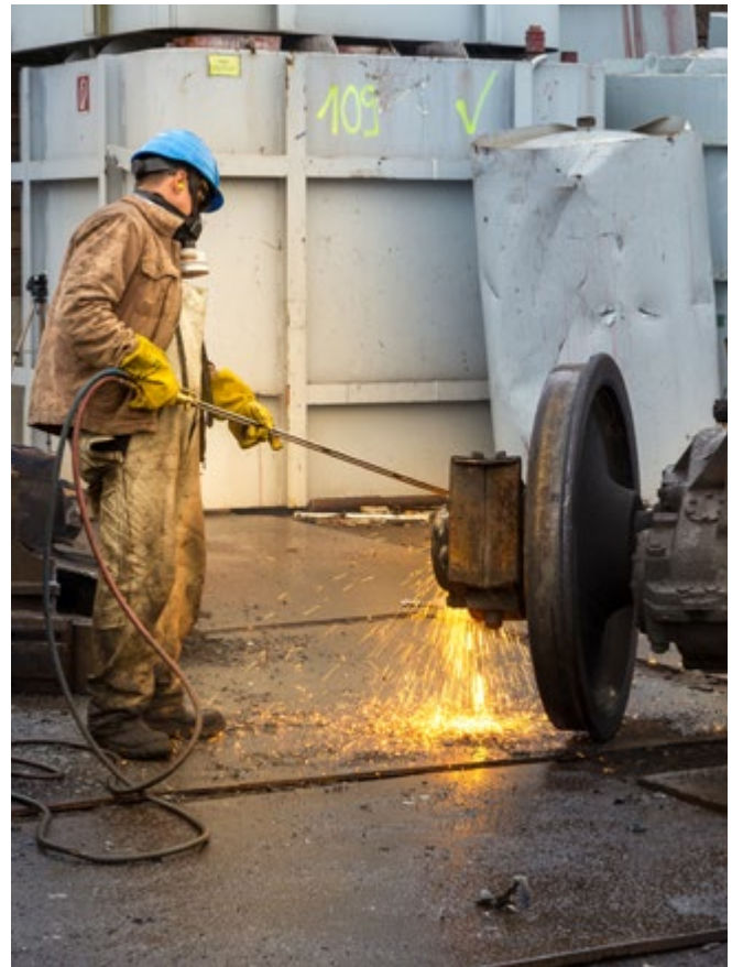
Abb. 56 Durch ausreichend lange Brennlanze ist aufrechte Position möglich
