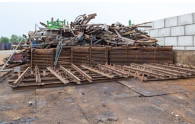
Abb. 54 Stationärer Brennschneidarbeitsplatz mit übersichtlich – außerhalb des allgemeinen Verkehrsbereiches – abgelegtem Schneidgut und sicherer Gestaltung des Verkehrsweges für den an- und abtransportierenden Bagger
