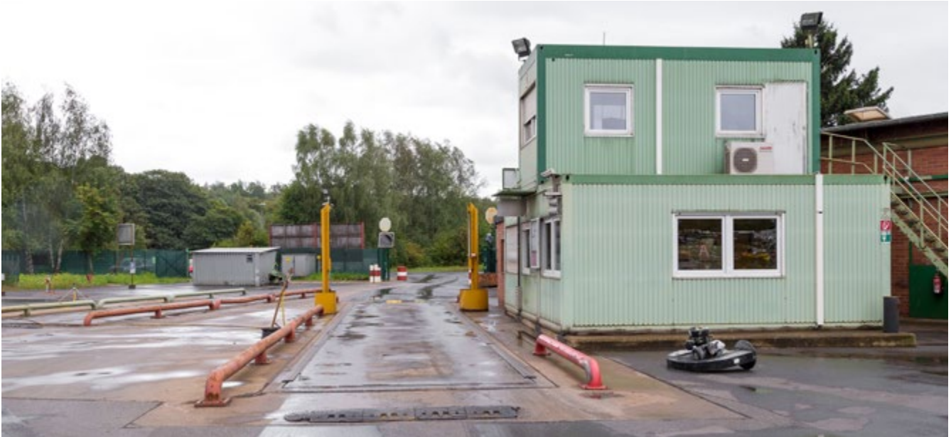
Abb. 21 Klar gegliederter Zufahrtsbereich mit Fahrzeugwaage und Detektoren zur Erkennung radioaktiver Strahlenquellen
