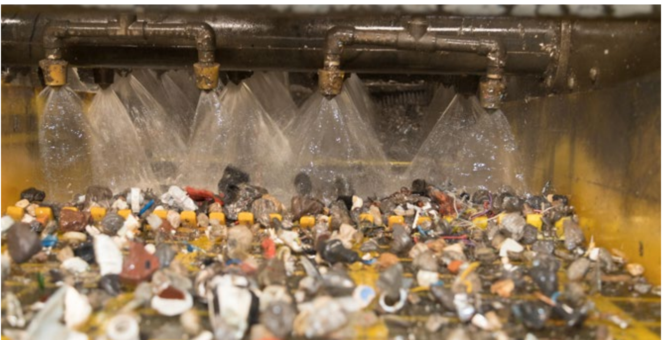
Abb. 85 Staubbinding durch Wasserbedüsung
