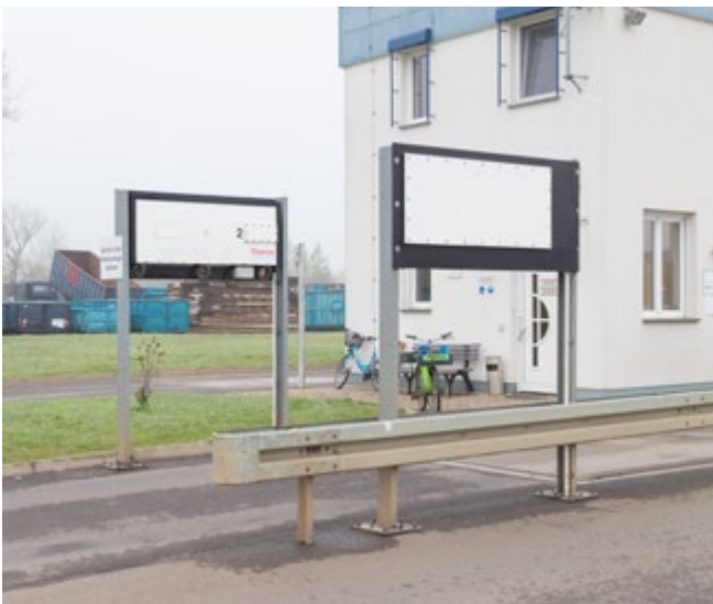
Abb. 20 Stationäre Messanlage für LKW an der Zufahrt
