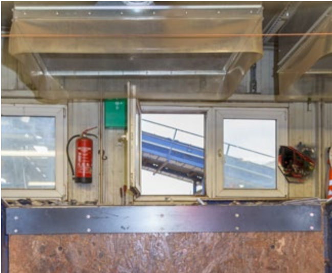
Abb. 46 Frischluftzufuhr von oben und Absaugung der Abluft im Fußbodenbereich
