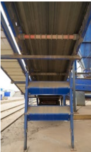
Abb. 41 Ungesicherte Untergurtrollen im Arbeits- und Verkehrsbereich sind gefährliche Einzugsstellen
