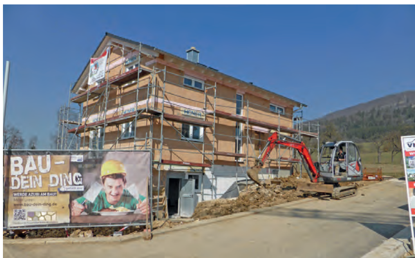
Abbildung E.10: Baustelle 10
