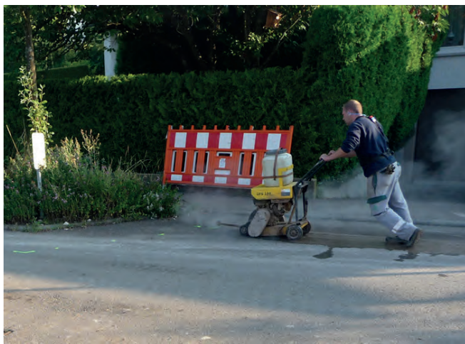
Abbildung B.11: Schneidarbeiten Straße
