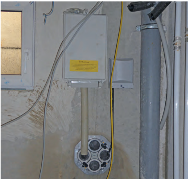
Abbildung E.9: Baustelle 10
