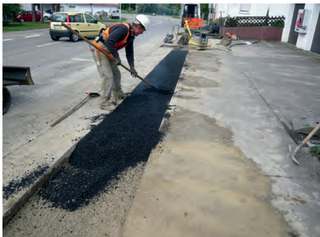
Abbildung B.41: Bitumen aufbringen
