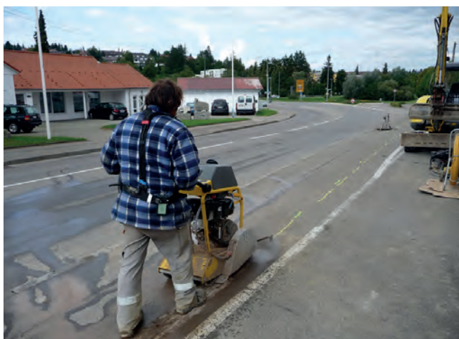
Abbildung B.38: Schneidarbeiten
