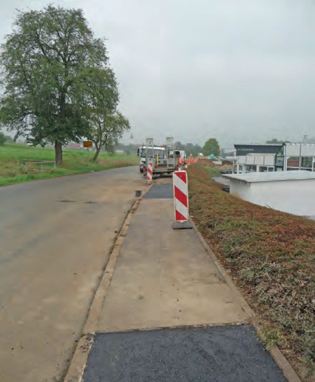
Abbildung E.7: Baustelle 5
