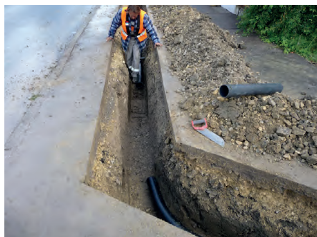
Abbildung B.30: Leerrohr verlegen
