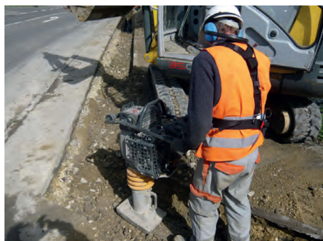
Abbildung B.33: Verdichtungsarbeiten
