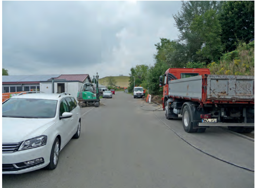
Abbildung E.1: Baustelle 1
