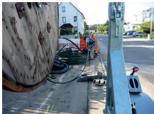
Abbildung B.36: Kabel verlegen
