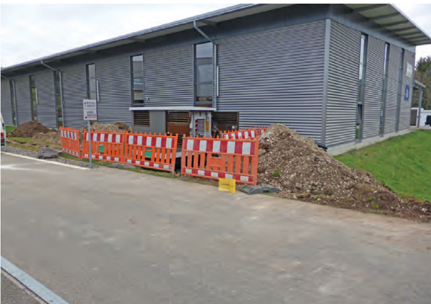
Abbildung E.16: Baustelle 14
