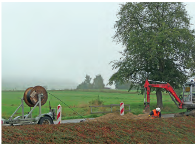
Abbildung B.44: Kabel einziehen
