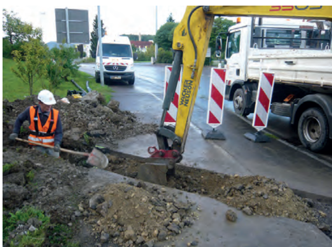
Abbildung B.32: Aushub- und Verfüllarbeiten
