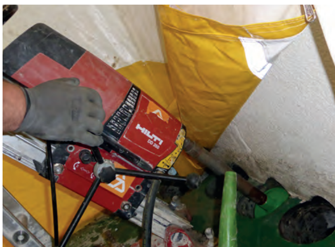
Abbildung B.80: Kernbohrung
