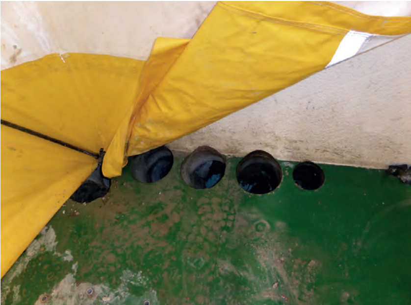
Abbildung E.15: Baustelle 13
