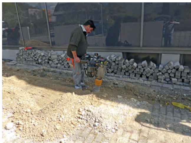
Abbildung B.78: Verdichtungsarbeiten
