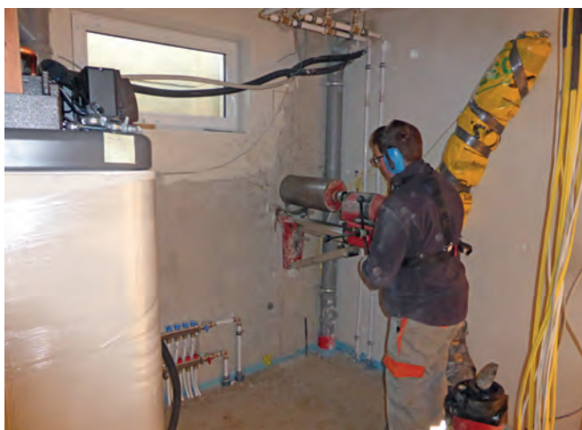
Abbildung B.56: Kernbohrung
