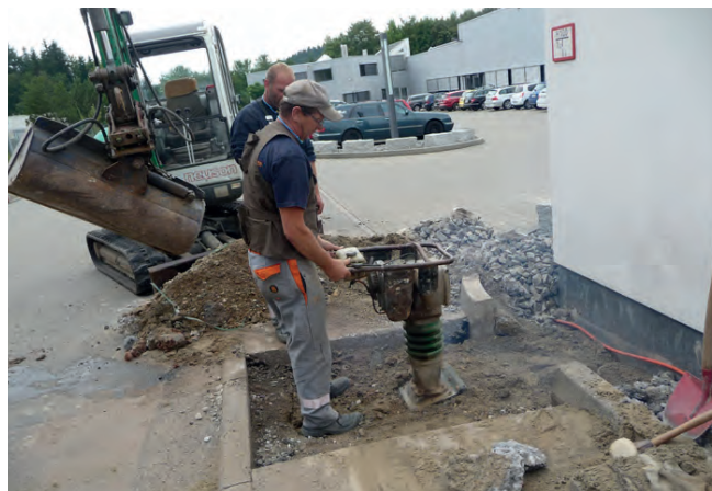
Abbildung B.6: Stampfer bedienen
