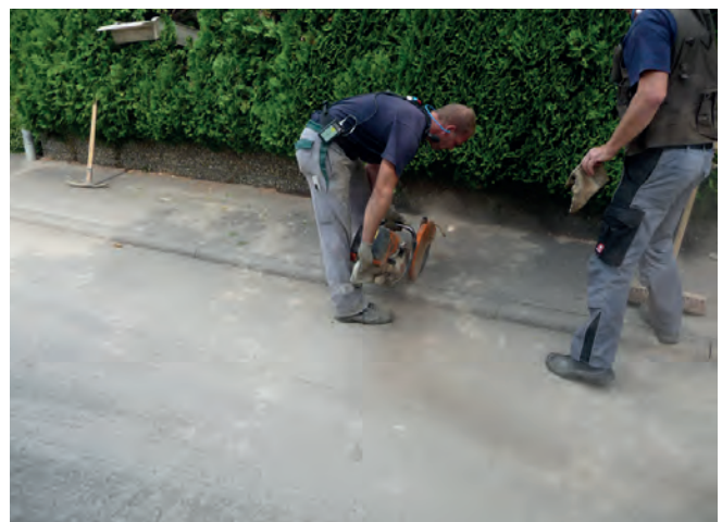
Abbildung B.21: Schneidarbeiten Gehweg
