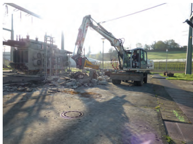
Abbildung B.63: Großbagger mit Vorsatzmeißel
