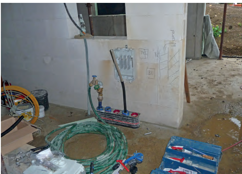
Abbildung E.8: Baustelle 6
