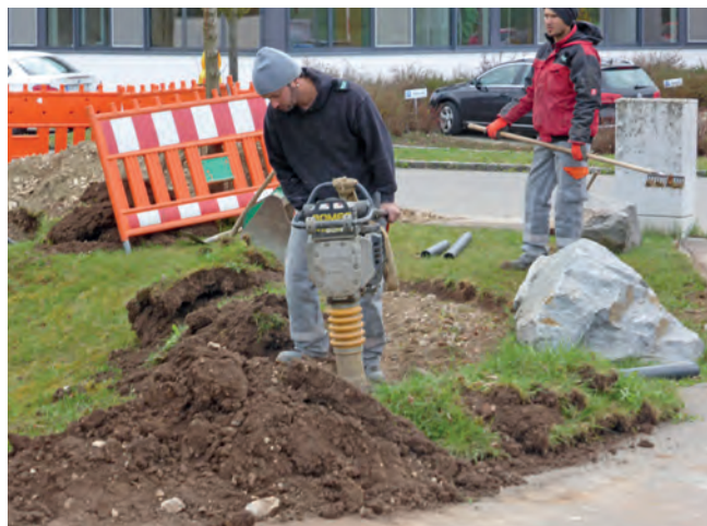
Abbildung B.84: Verdichtungsarbeiten
