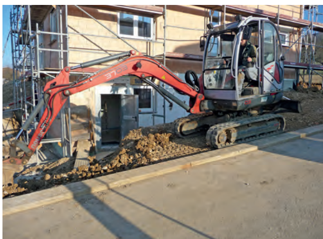
Abbildung B.59: Minibagger bedienen
