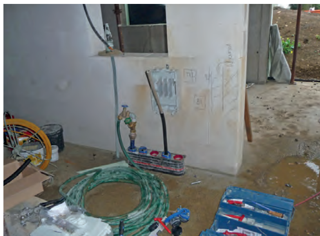
Abbildung B.53: Montage Hausanschlusskasten
