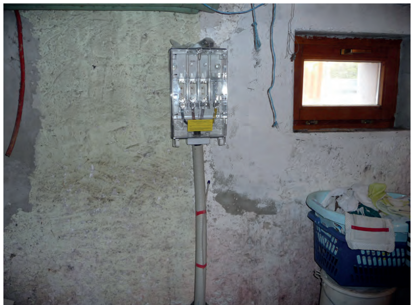
Abbildung E.6: Baustelle 4
