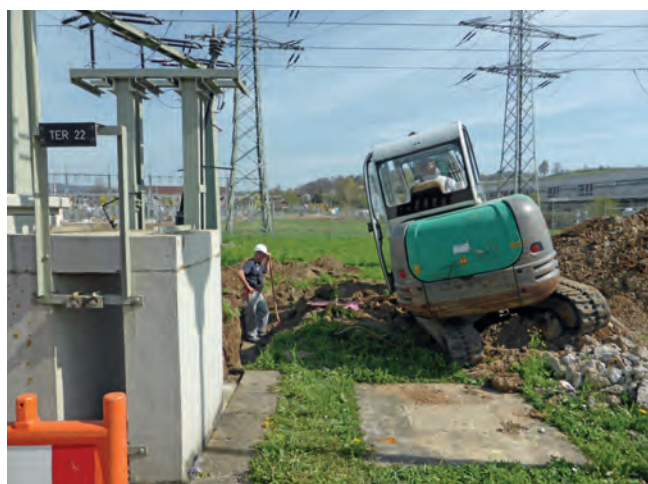
Abbildung B.66: Aushub- und Verfüllarbeiten
