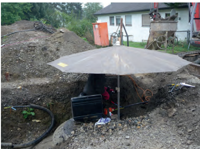
Abbildung B.50: Kabel anschließen
