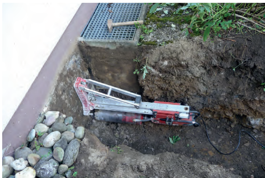
Abbildung E.4: Baustelle 3
