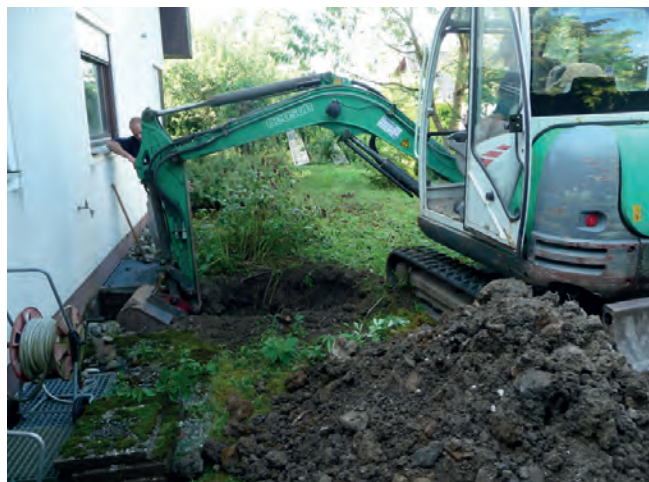
Abbildung B.24: Minibagger bedienen
