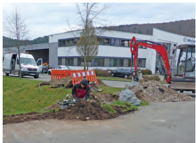
Abbildung B.87: Verdichtungsarbeiten
