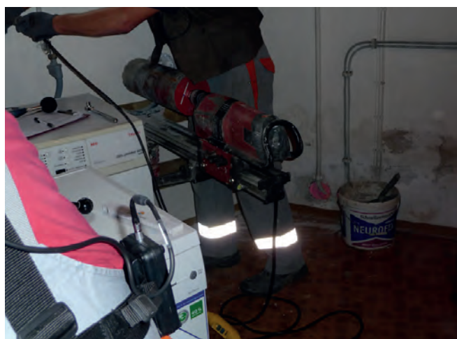
Abbildung B.17: Kernbohrung
