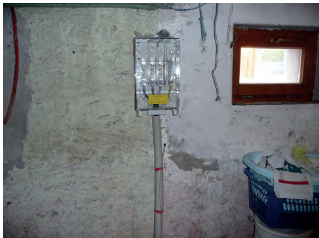
Abbildung B.42: Hausanschlusskasten setzen
