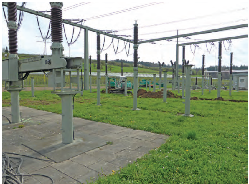
Abbildung E.14: Baustelle 12
