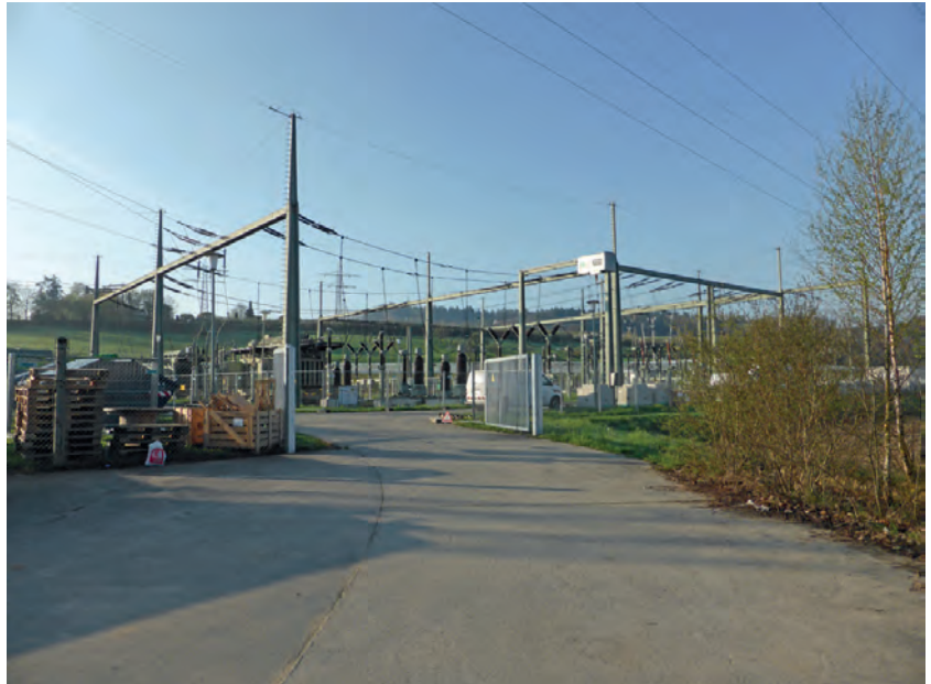
Abbildung E.13: Baustelle 12
