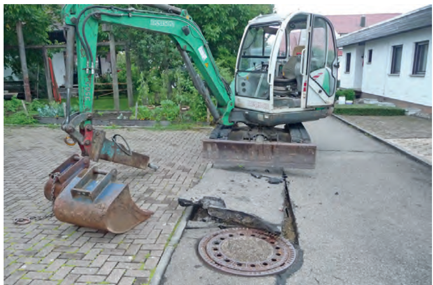
Abbildung E.2: Baustelle 2
