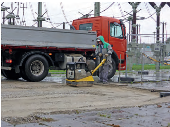
Abbildung B.74: Rüttelplatte bedienen
