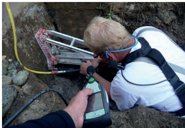
Abbildung B.27: Kernbohrung
