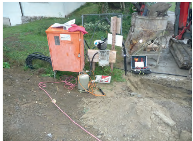
Abbildung B.51: Baustrom anschließen
