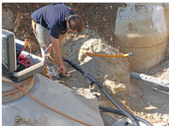
Abbildung B.60: Kabelanschlussarbeiten
