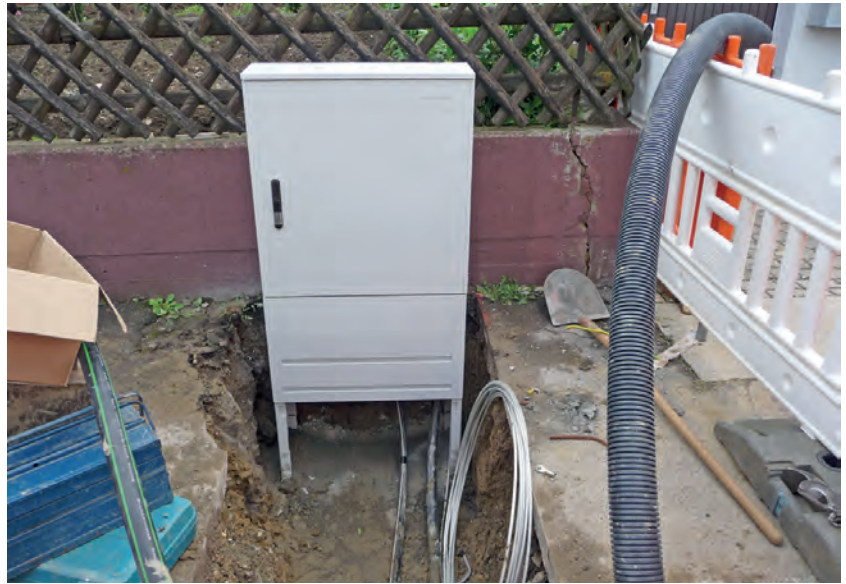
Abbildung E.5: Baustelle 4
