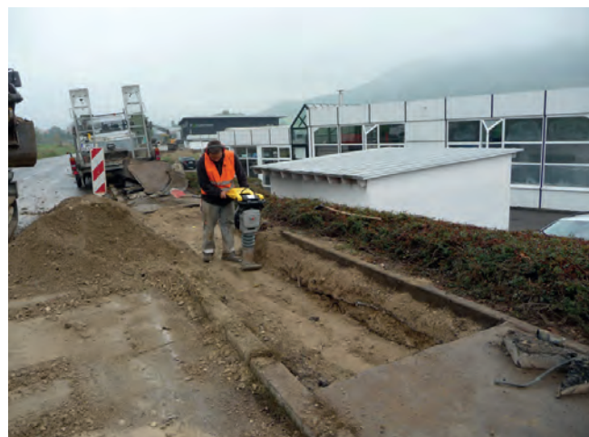
Abbildung B.48: Verdichtungsarbeiten
