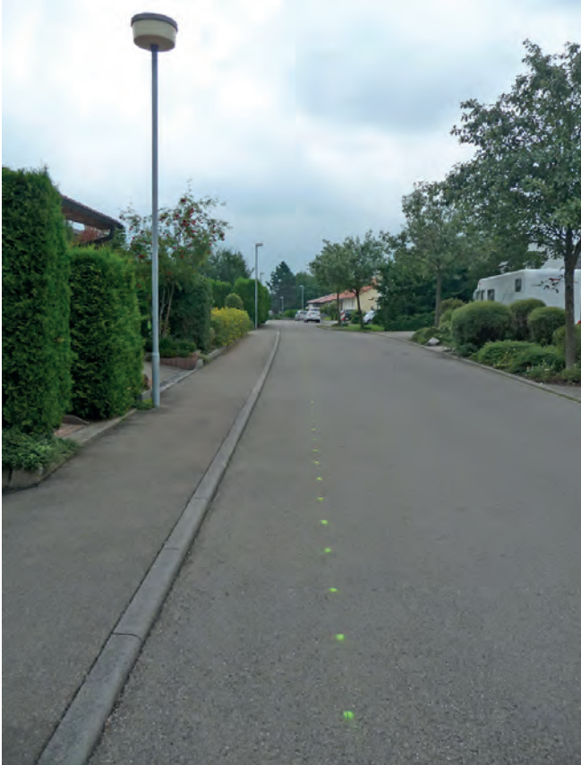
Abbildung E.3: Baustelle 3
