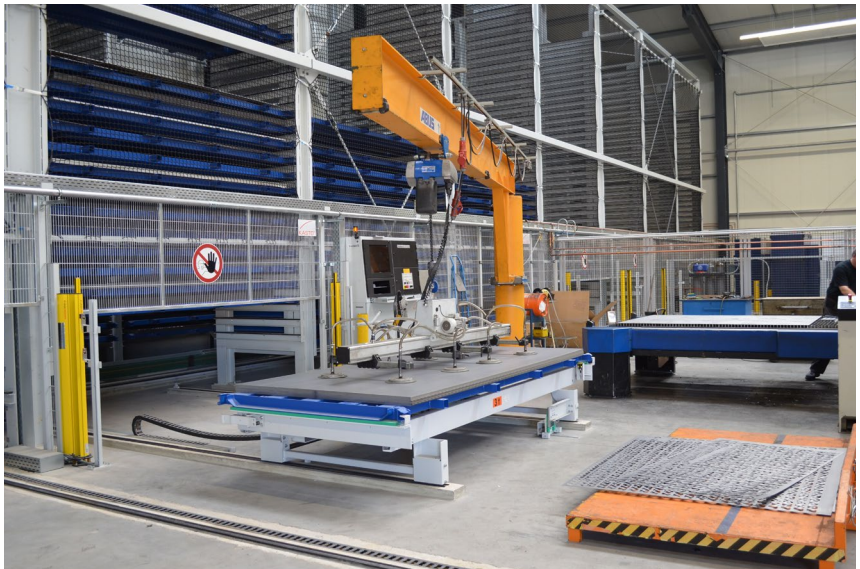
Abb. 17 Beispiel einer Station mit Auslagerungsstelle, an der Beschäftigte mit einem Säulendrehkran und einem Vakuumsauger die Blechtafel zur Bearbeitung umlagern können
