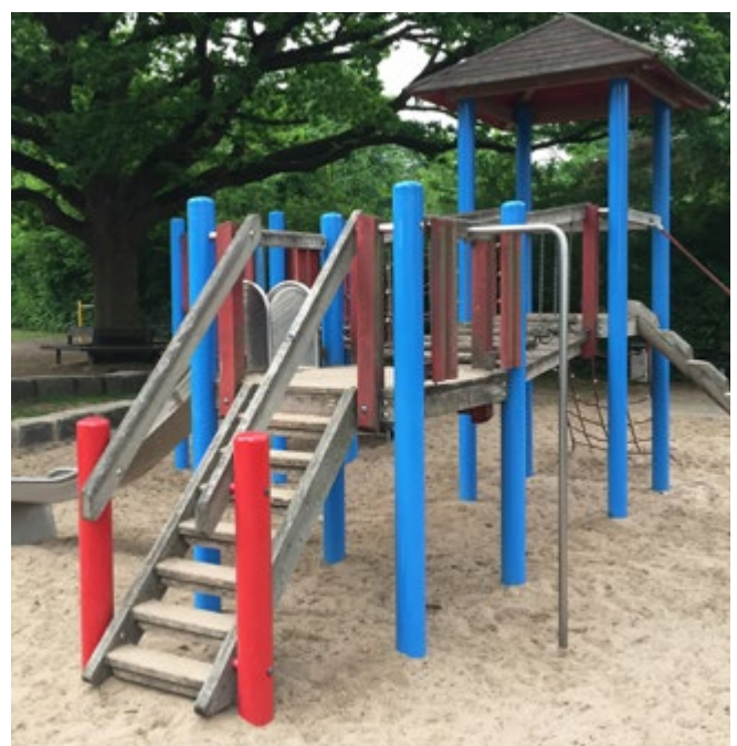
Abb. 31 Bei Klettergeräten ist ein entsprechender Untergrund erforderlich.
