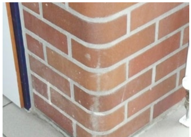
Abb. 10 Glatte Oberflächen und gerundete Kanten beugen Verletzungen vor.
