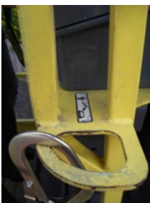
Abbildung 2 - Anschlagpunkte für PSAgA
