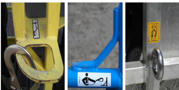
Bild 3: Verschiedene Anschlagpunkte für PSAgA
