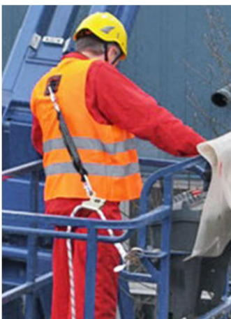
Bild 5: In der Länge verstellbares Verbindungsmittel mit energieabsorbierender Funktion
