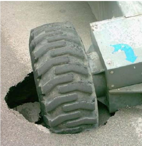
Bild 3: Eingebrochenes Rad einer FHAB aufgrund eines Hohlraumes
