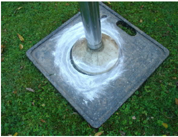
Bild 6: Mittige Auflage erzeugt gleichmäßige Lastverteilung
