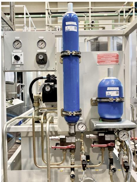
Abbildung 1 – Ölhydraulischer Druckspeicher
