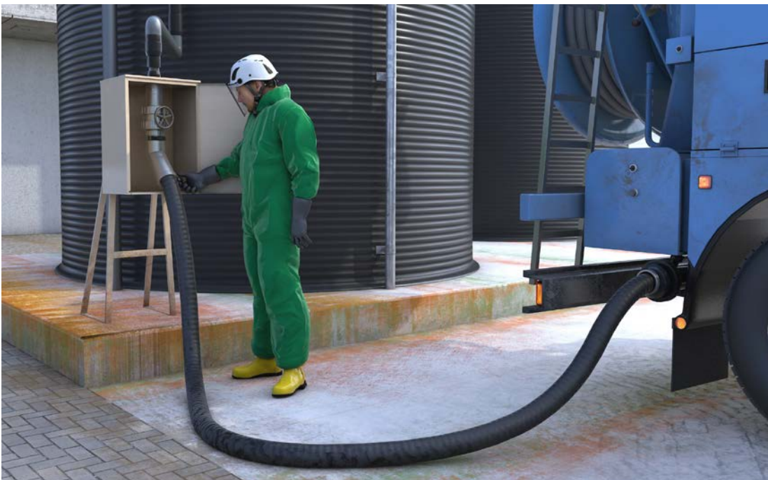
Abb. 16 Bei der Anlieferung von Fällmitteln sind umfangreiche Schutzmaßnahmen angezeigt.
