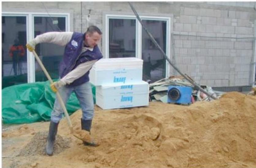
**Abbildung 3.3.3-5:** Estrichleger mit typischer Schaufelhandhabung beim Befüllen der Estrichmaschine (aus Glitsch et al. 2008)
