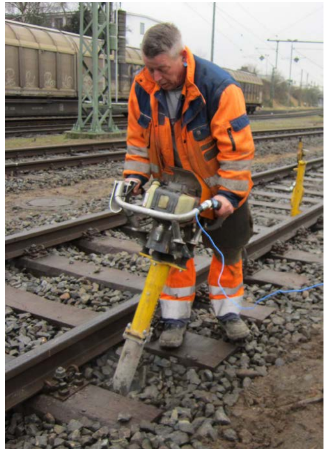
Einsatz eines Vertikal-Schwingstopfers (Bild: IFA)
