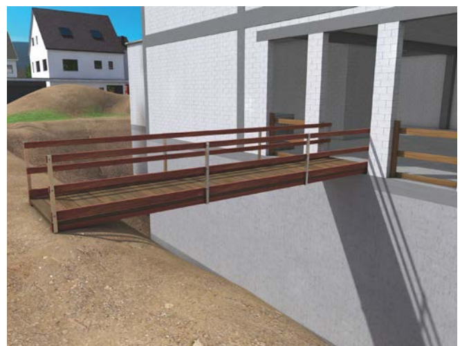
Abb. 81 Laufsteg mit Seitenschutz als Verkehrsweg
