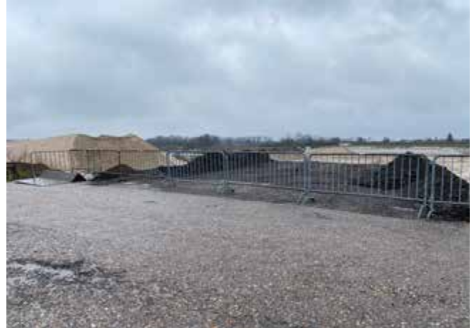
Abb. 12 Absperrung der Kippstelle bei Entnahme von Material am Haldenfuß
