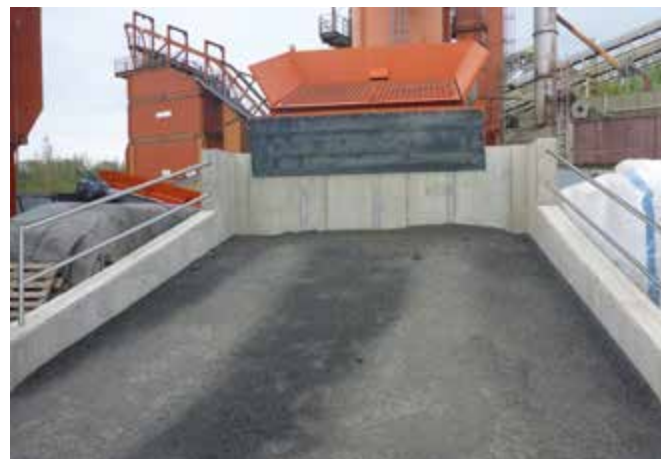
Abb. 8 Rampe mit seitlichem Überfahrerschutz
