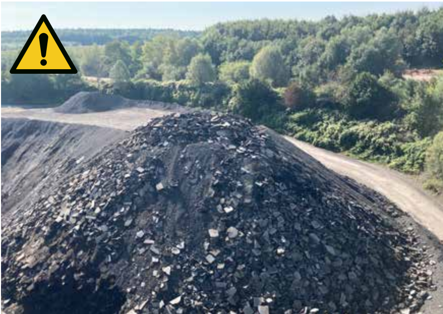
Abb. 9 Gefahr durch zu hohe Wandhöhen bei nicht selbständig nachrutschendem Material
