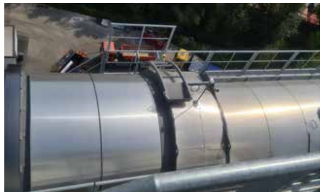
Abb. 76 Zugang zu Wartungsplatz, erhöhtes Gelände
