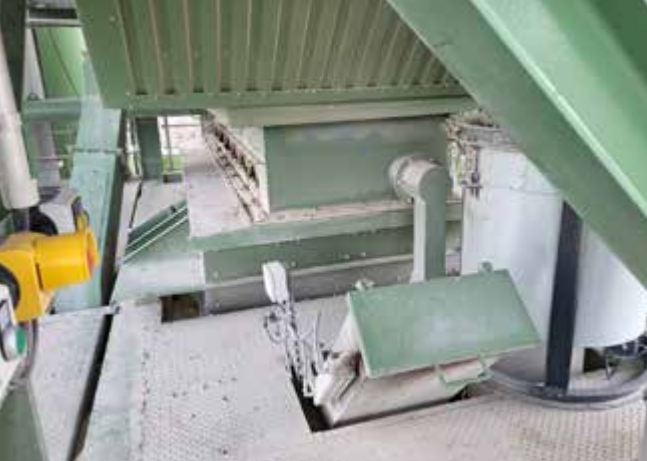
Abb. 49 Zugabeschleuse für Sackware mit abgesetztem Quittiertaster (linker Bildrand)
