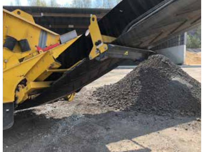
Abb. 57 Gut gesichertes Austragsband der mobilen Anlage
