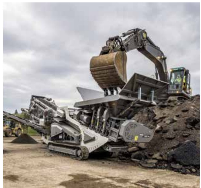
Abb. 55 Materialaufgabe mit Bagger von sicherer Standfläche
