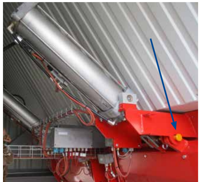
Abb. 70b Sicherung der Auslaufklappe mit Bolzen (Pfeil)
