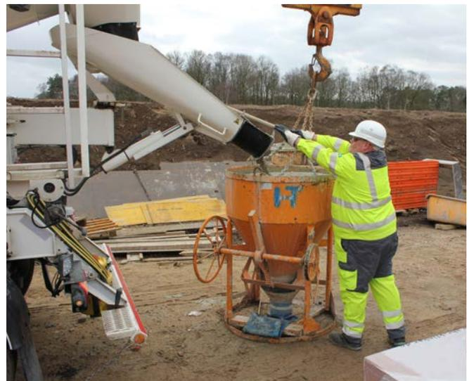
Abb. 19 Befüllung des Betonkübels
