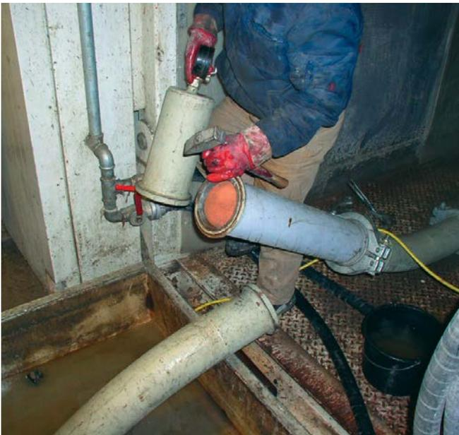
Abb. 37 Einsatz des Reinigungsschwammes
