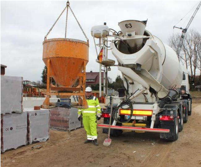
Abb. 18 Betonkübel am Baustellenkran
