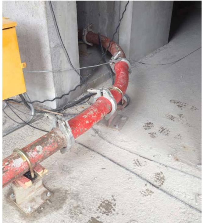
Abb. 35 Rohrbefestigung für den Betoniervorgang
