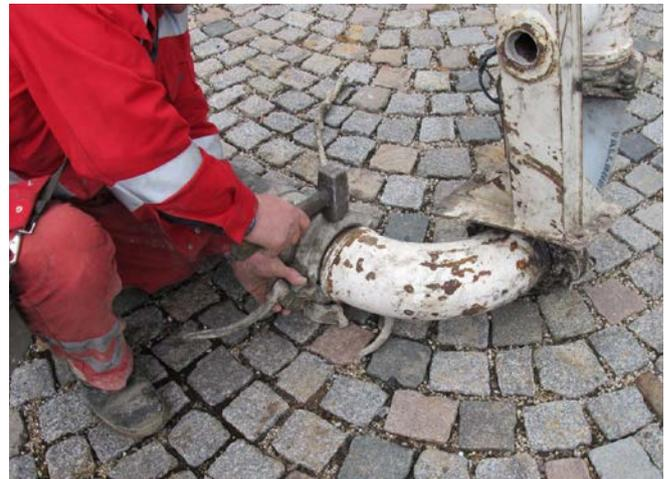
Abb. 33 Lärmeinwirkung beim Lösen einer Rohrkupplung
