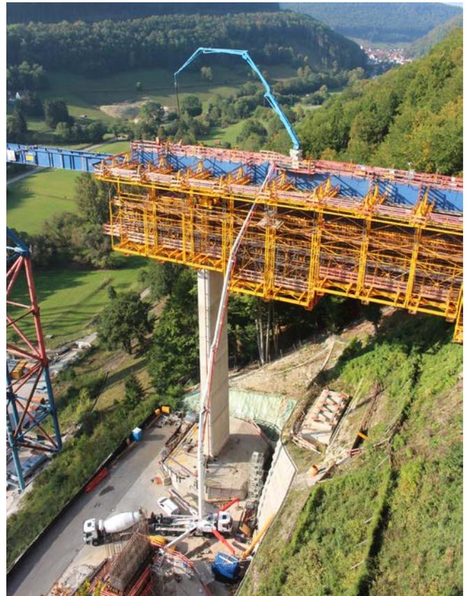
Abb. 1 Brückenbaustelle mit Betonpumpeneinsatz und Frischbetonversorgung durch Fahrmischer
