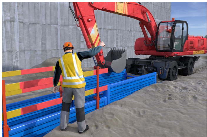
Abb. 25 Grabenverbau- geräte und Absturz- sicherung
