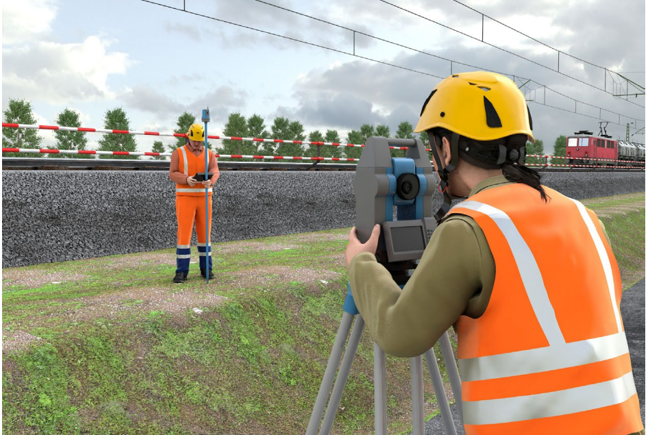
Abb. 28 Vermessungsarbeiten im Bereich von Gleisen
