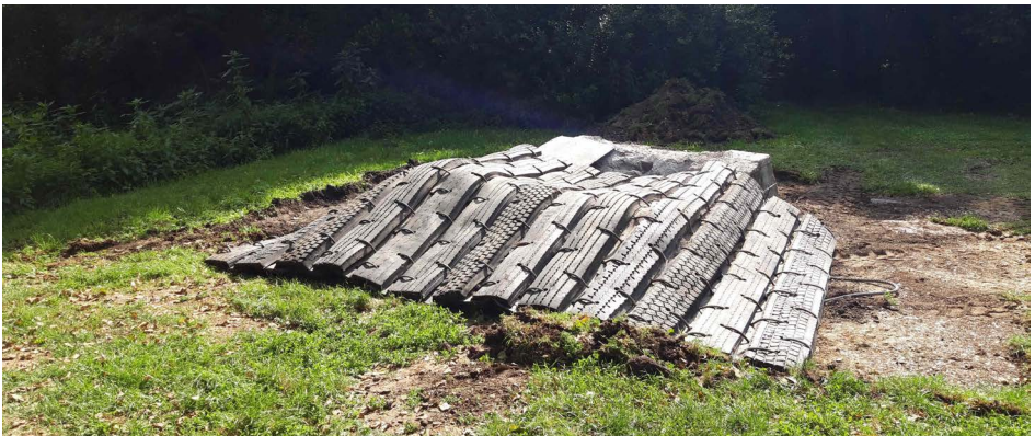
Abb. 32 Einsatz einer Sprengschuttmatte
