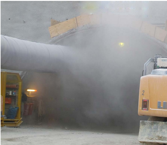
Abb. 40 Abziehende Sprengschwaden am Tunnelportal
