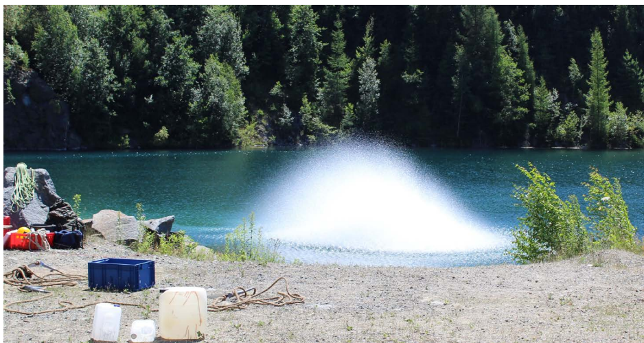
Abb. 42 Sprengung unter Wasser
