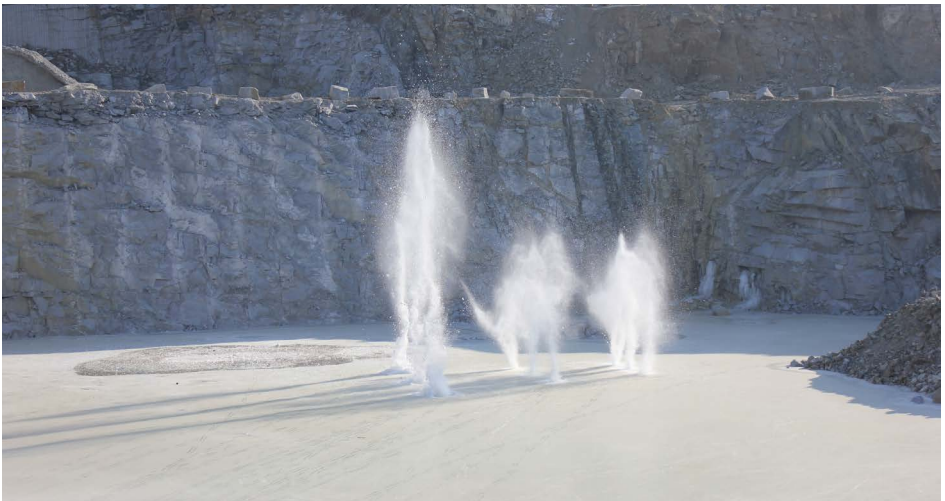
Abb. 44 Eissprengung
