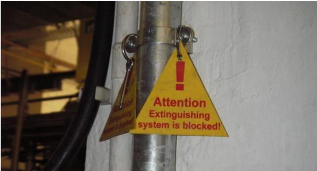
Bild 3: Blockieren der Löschanlage
