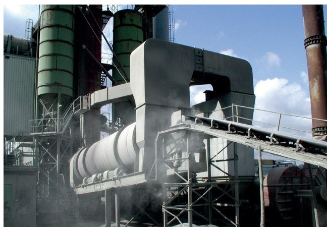
Abbildung 10: Trockentrommel einer Asphaltmischanlage
