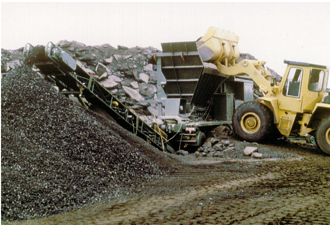
Abbildung 50: Brecherbeschickung beim Baustoffrecycling
