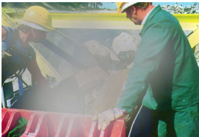
Abbildung 51: Manuelle Aussortierung beim Baustoffrecycling
