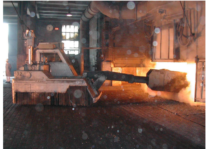
Abbildung 34: Anlage zur elektrothermischen Herstellung von Si-Verbindungen
