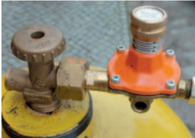
Bild 7-3: Mitteldruckregler mit einstellbarem Druck an einer Großflasche
