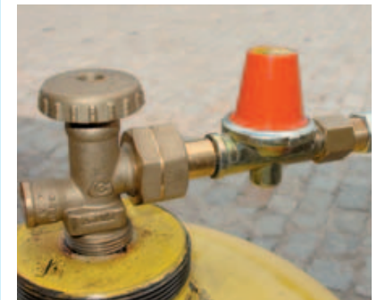
Bild 7-2: Fest eingestellter Mitteldruckregler an einer Großflasche
