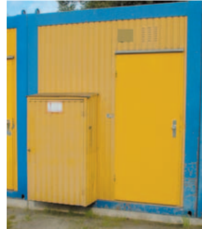
Bild 10-9: Außen angebrachter Flaschenschrank an einem Baucontainer
