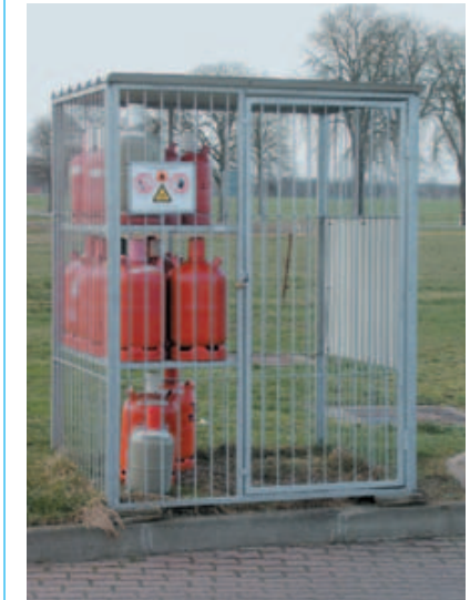
Bild 4-9: Lagerung von Flüssiggasflaschen im Freien
