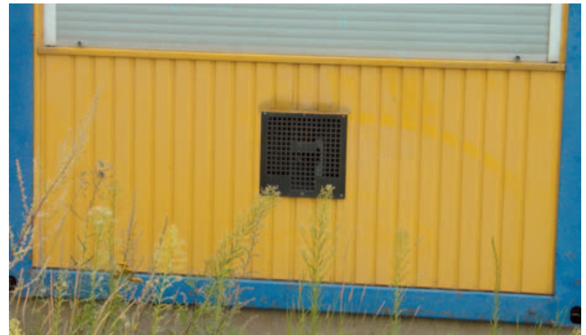
Bild 10-10: Baucontainer mit Lüftungs- und Abgasöffnung für Gas-Beheizung
