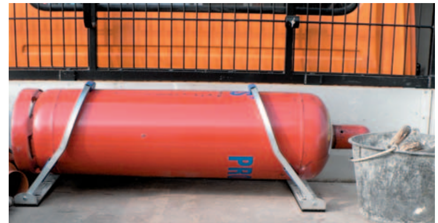
Bild 4-13: Großflasche quer liegend und durch eine Halterung gegen Lageveränderungen gesichert (Quelle: Marotech)
