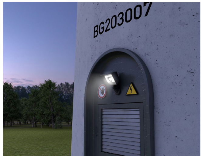
Abb. B4-1 Zugang mit ausreichender Außenbeleuchtung
