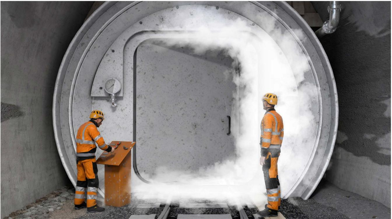
Abb. 5 Materialschleuse (atmosphärische Seite) nach dem Öffnen der Schleusentür
