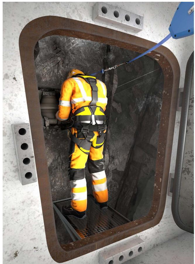
Abb. 8 Durchführen des Werkzeugwechsels im oberen Schildquerschnitt
