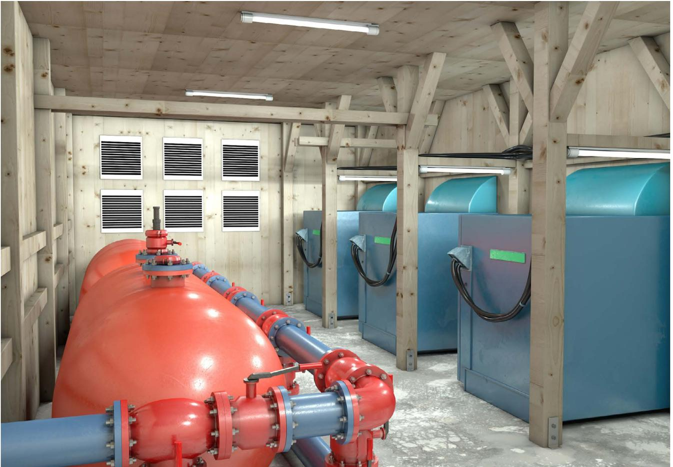
Abb. 1 Vor Sonneneinstrahlung geschützte Kompressoranlage und Druckbehälter
