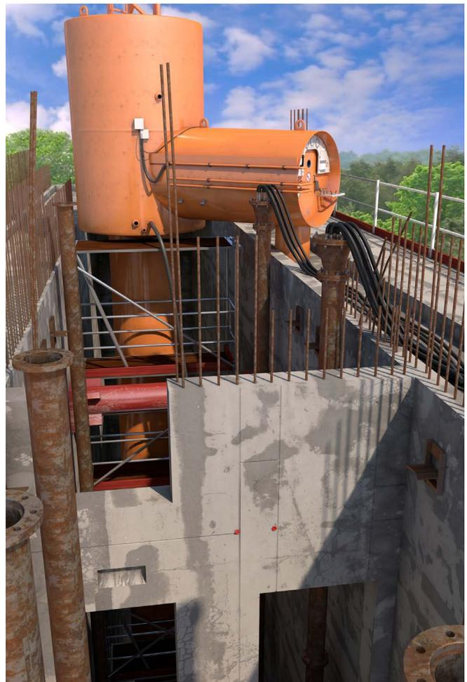
Abb. 13 Personenschleuse und vertikales Schachtt Rohr eines Senkkastens
