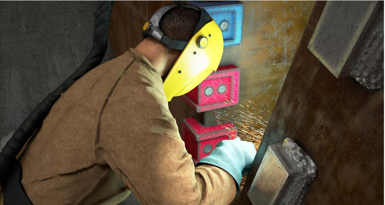
Abb. 3 Schweißarbeiten in Druckluft mit umgebungsluftunabhängiger Atemluftversorgung
