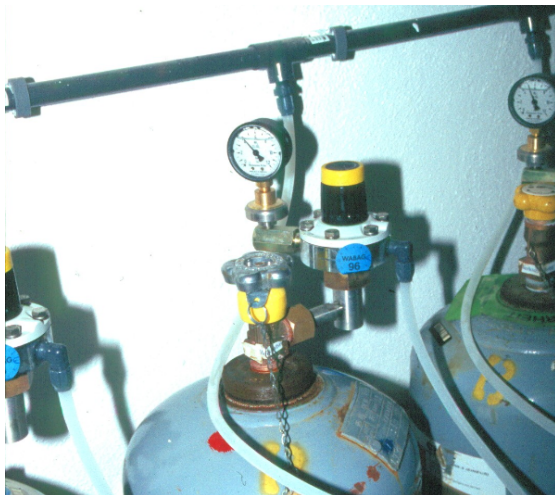
Abbildung 2 – Flaschenventil und Vakuumentregelventil
