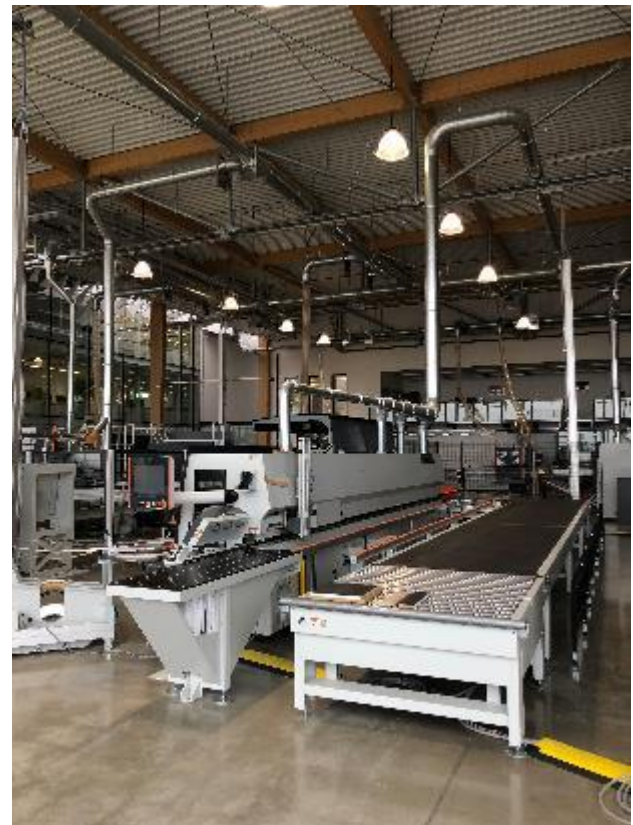
Abbildung 14 – Beispiel der Zugangssicherung durch Lichtschranken und feststehende Schutzeinrichtungen
