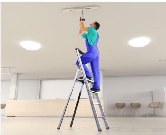
Abb. 57 Sicherer Stand auf der Stehleiter mit Plattform
