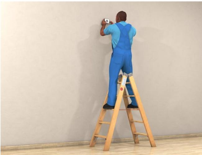
Abb. 56 Sicherer Stand auf einer beidseitig begehbaren Stufenstehtleiter
