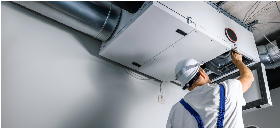
Abbildung 4 – Wartung einer RLT-Anlage
