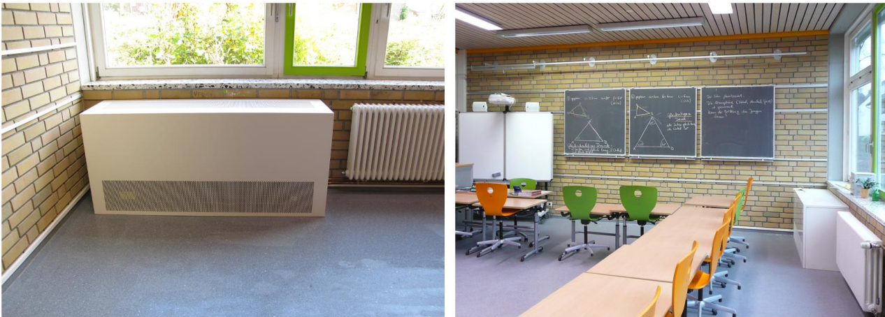
Abbildung 5 – Nachrüstung eines dezentralen Lüftungsgeräts mit Wärmerückgewinnung in einem Klassenzimmer
