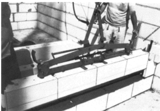
Bild 12: Greifzange mit zwei Dornen für drei und vier Steine
