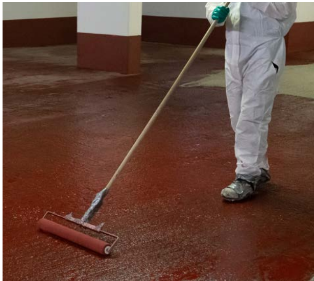
Abb. 6 Verteilen des Harzes mit langstieligen Werkzeugen
