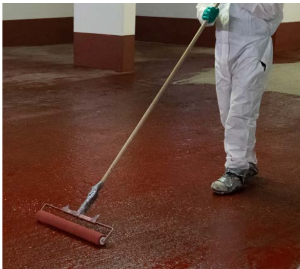
Abb. 6 Verteilen des Harzes mit langstieligen Werkzeugen
