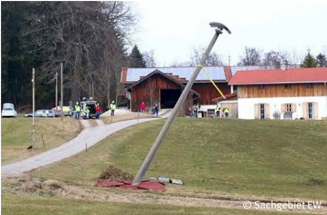
Versuch zum Sprengen eines Freileitungsmastes
