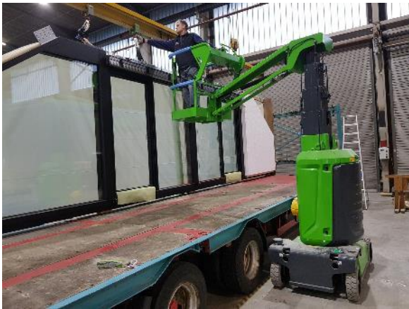
Abbildung 20 – Hubarbeitsbühne Fertigteil kann direkt durch Ausleger erreicht werden, verfahrbar, sicherer Arbeitsplatz
