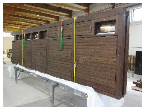
Abbildung 19 – Herunterhängende Anschlagmittel Kein Aufstieg auf das Ladegut erforderlich, Anschlagmittel sind bereits vorkonfektioniert.
