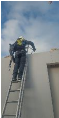
Abbildung 31 – Stufenanlegeleiter Ausreichend dimensionierte Leiter mit Fußverbreiterung, Stufen und möglichst Leiterkopffixierung am Fahrzeug (Haken, Seile)
