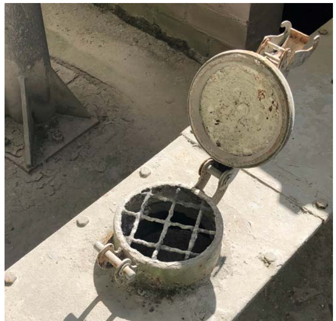
Abb. 35 Durch Gitter gesicherte Kontrollöffnung
