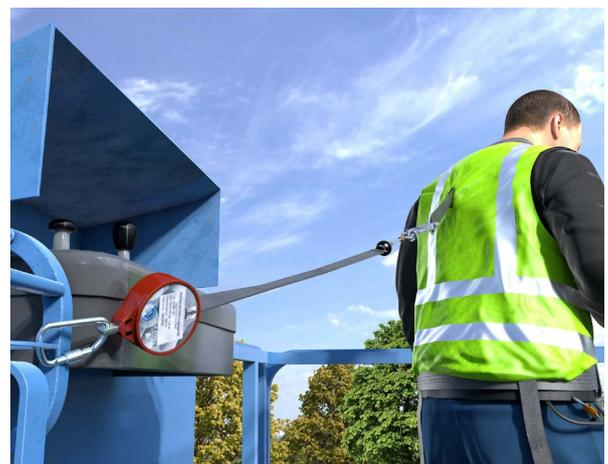
Abb. 9 Einsatz eines Höhensicherungsgeräts im Arbeitskorb
