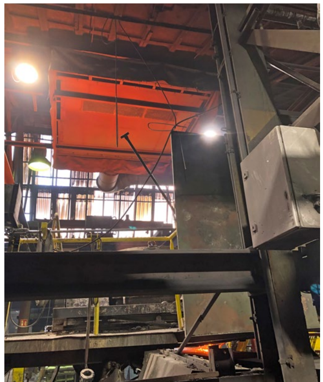
Abb. 11 Erfassungshaube im Schmelzbetrieb
