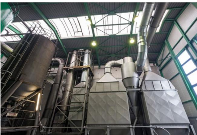
Abb. 16 Absauganlage in einer Gießerei
