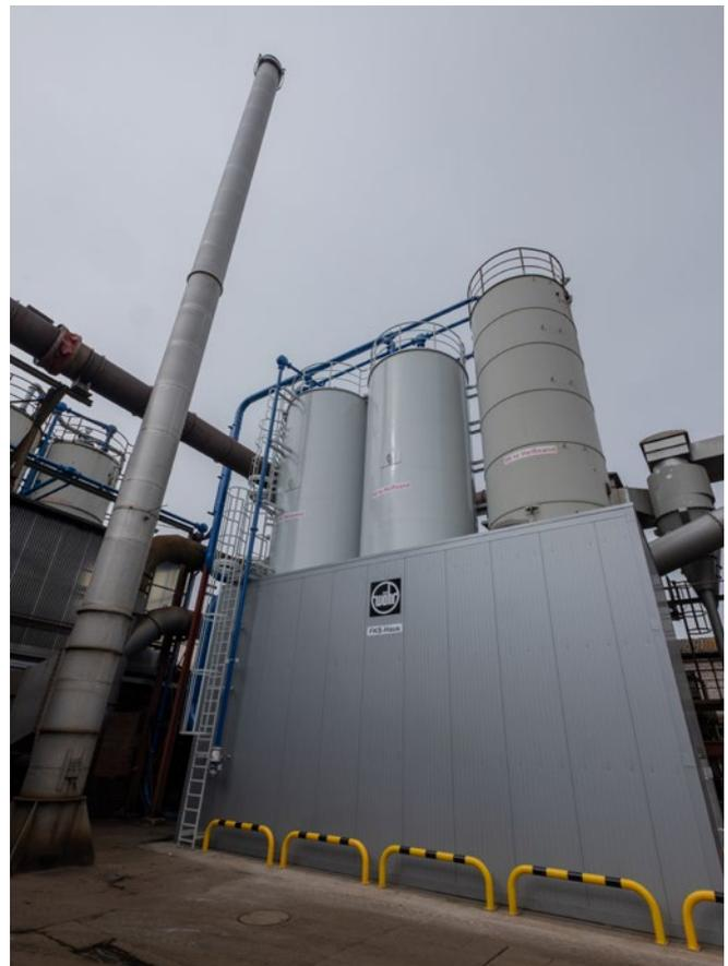
Abb. 18 Sand-Silo und Formstoff-Mischstation im Außenbereich
