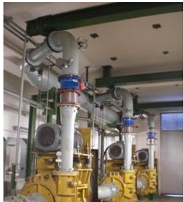
Abbildung 1 – Ausbauträger in Pumpenstation
