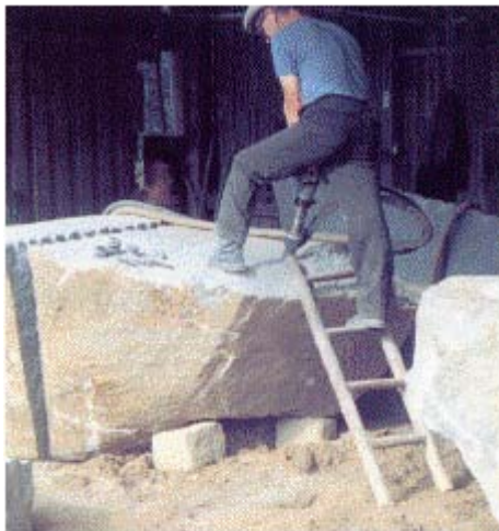
Abb. 33: Sicherer Zugang und Unterfütterung des Rohblocks
