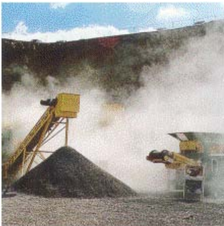
Abb. 6: Staubentwicklung beim Betrieb einer Recyclinganlage ohne Staubschutzmaßnahmen
