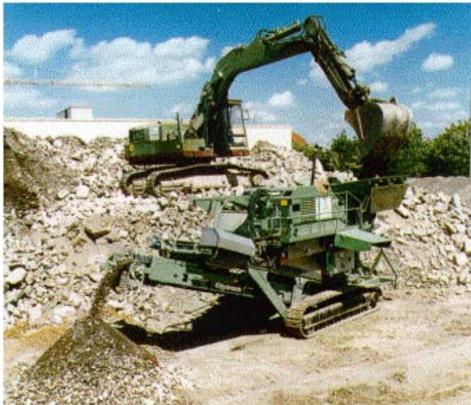
Abb. 17: Beispiel für die erhöhte Aufstellung des Baggers
