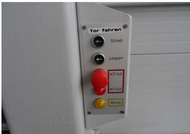
Abb. 12 Mit „Totmannschaltern“ oder Abschaltleisten lassen sich Unfälle an beweglichen Hallentoren vermeiden
