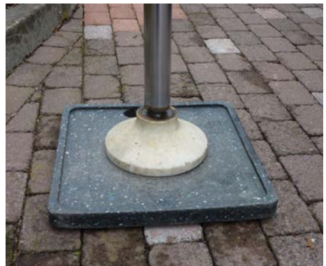
Bild 4-6 ausreichende Lastverteilung
