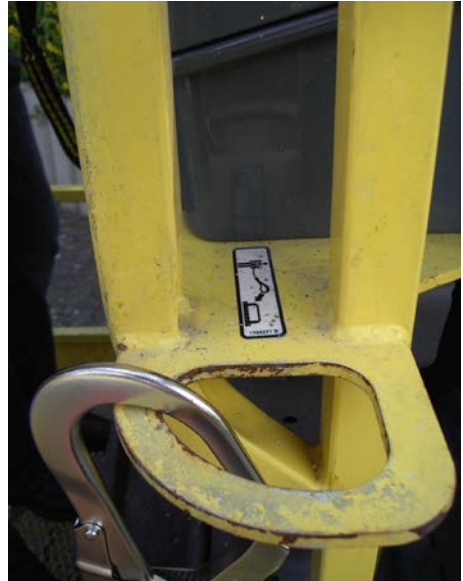
Bild 9-4 Anschlagpunkte
