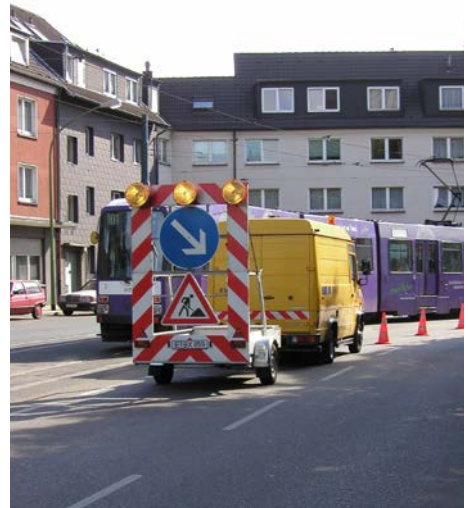
Bild 4-8 Absicherung im öffentlichen Straßenverkehr
