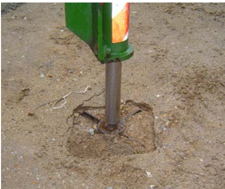
Bild 4-5 mangelhafte Lastverteilung
