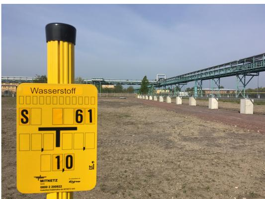
Abbildung 1 – Hinweisschild erdverlegte Wasserstoffleitung
