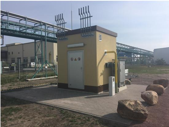
Abbildung 2 – Gas-Druckregel- und Messanlage
