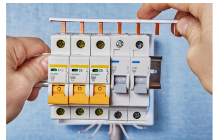
Abb. 22 Montage eines Schienenelements
