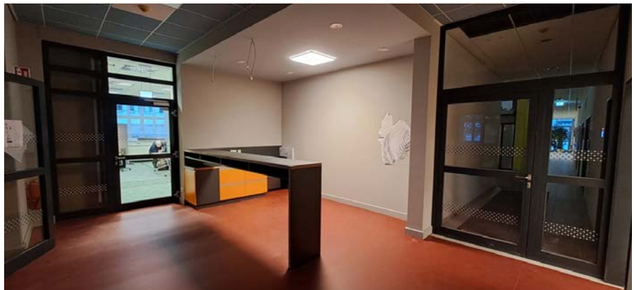
Abbildung 3: Baustellenbild Meet-Area. Quelle: T. Fietz
