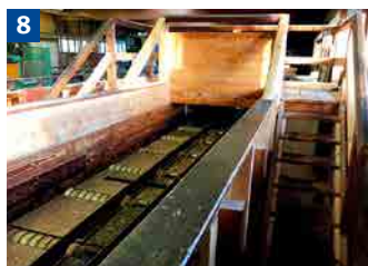
Fördereinrichtung mit sicherem Übergang
