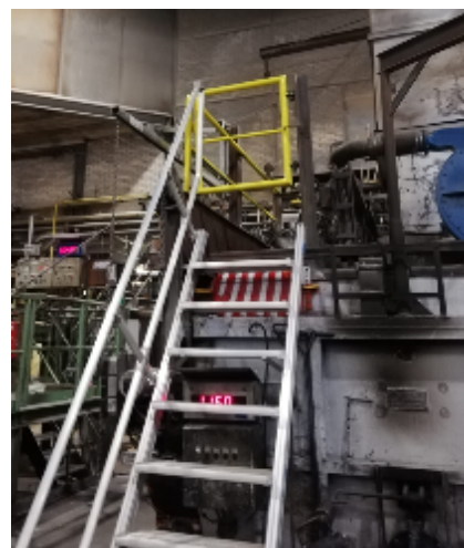
Abbildung 44 – Geländer und Durchgangssperre, Tür verriegelt (zweiter Handlauf wird nachgerüstet)
