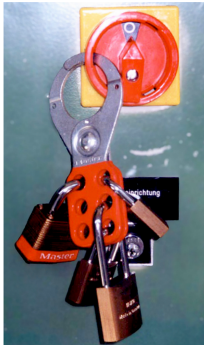
Abb. 7 Bügelschloss: Lockout-Tagout-System
