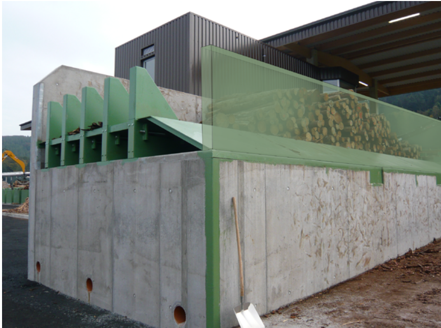
Abb. 3 Betonwände sichern den Gefahrenbereich unterhalb der Rundholzzuführung, hier in Grün virtuell dargestellt: Installation einer Wand zur Absicherung gegen herabfallende Stämme
