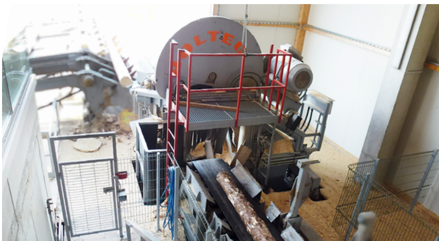
Abb. 2 Sicherung einer Rundholz-Kappanlage mit Aufstieg
