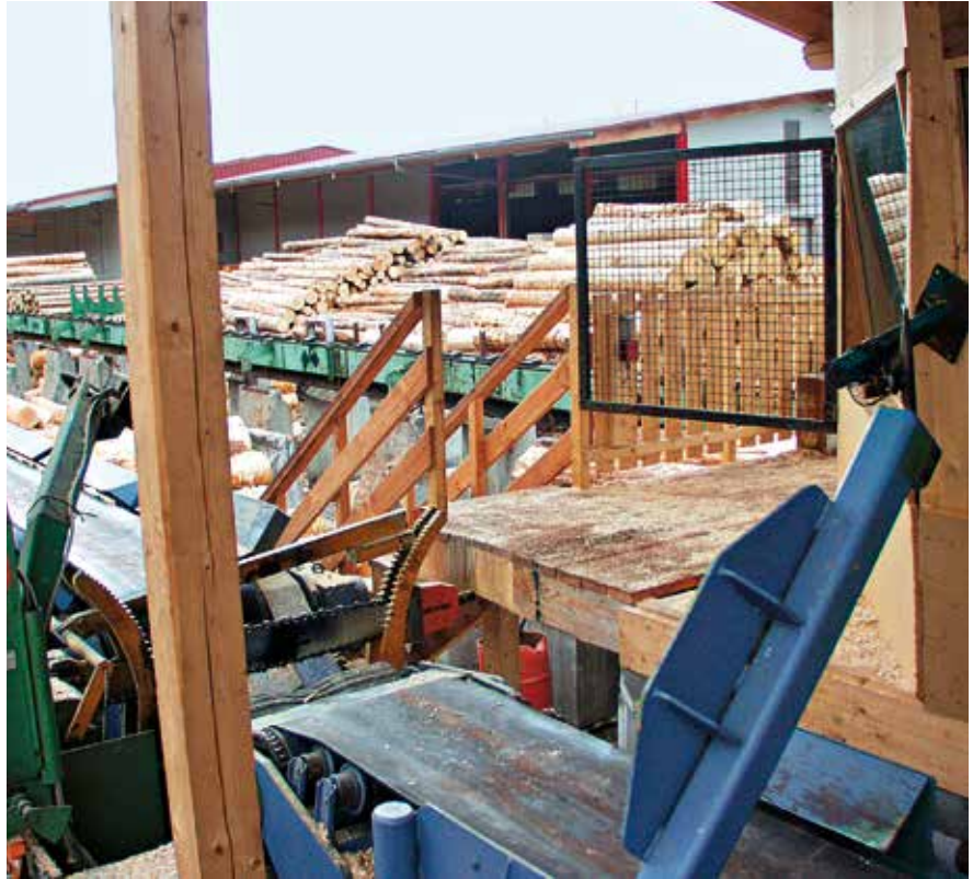
Bild 24: Elektrisch verriegelte Zugangstür zu einer Kappstation (innerhalb des Gefahrenbereiches fotografiert)
