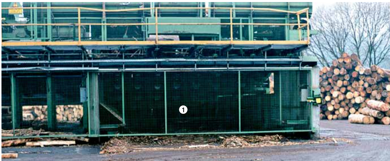
Bild 32: Unterer Bereich Rundholzzubringung
