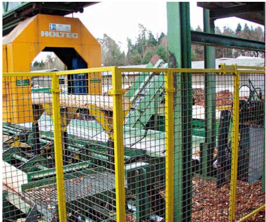
Bild 23: Verfahrbare Vermessung mit Umzäunung und elektrisch verriegelter Zugangstür
