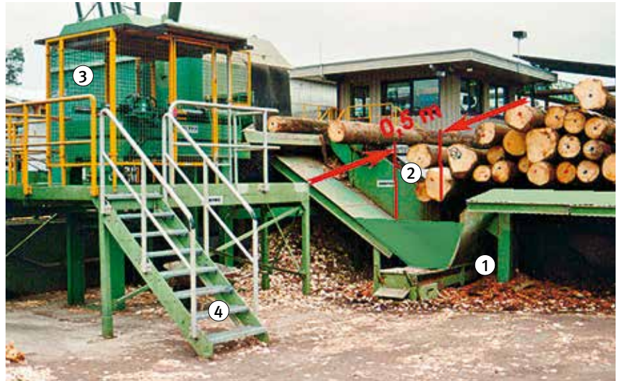
Bild 14: Gefährstellen der Fallstufe mit distanzierender Schutzeinrichtung gesichert.
