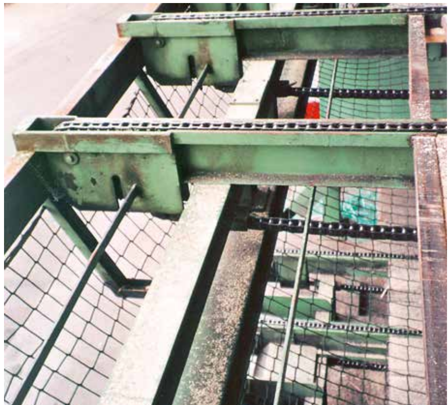
Bild 3: Netz als Absturzicherung an erhöhten Stapelbereichen
