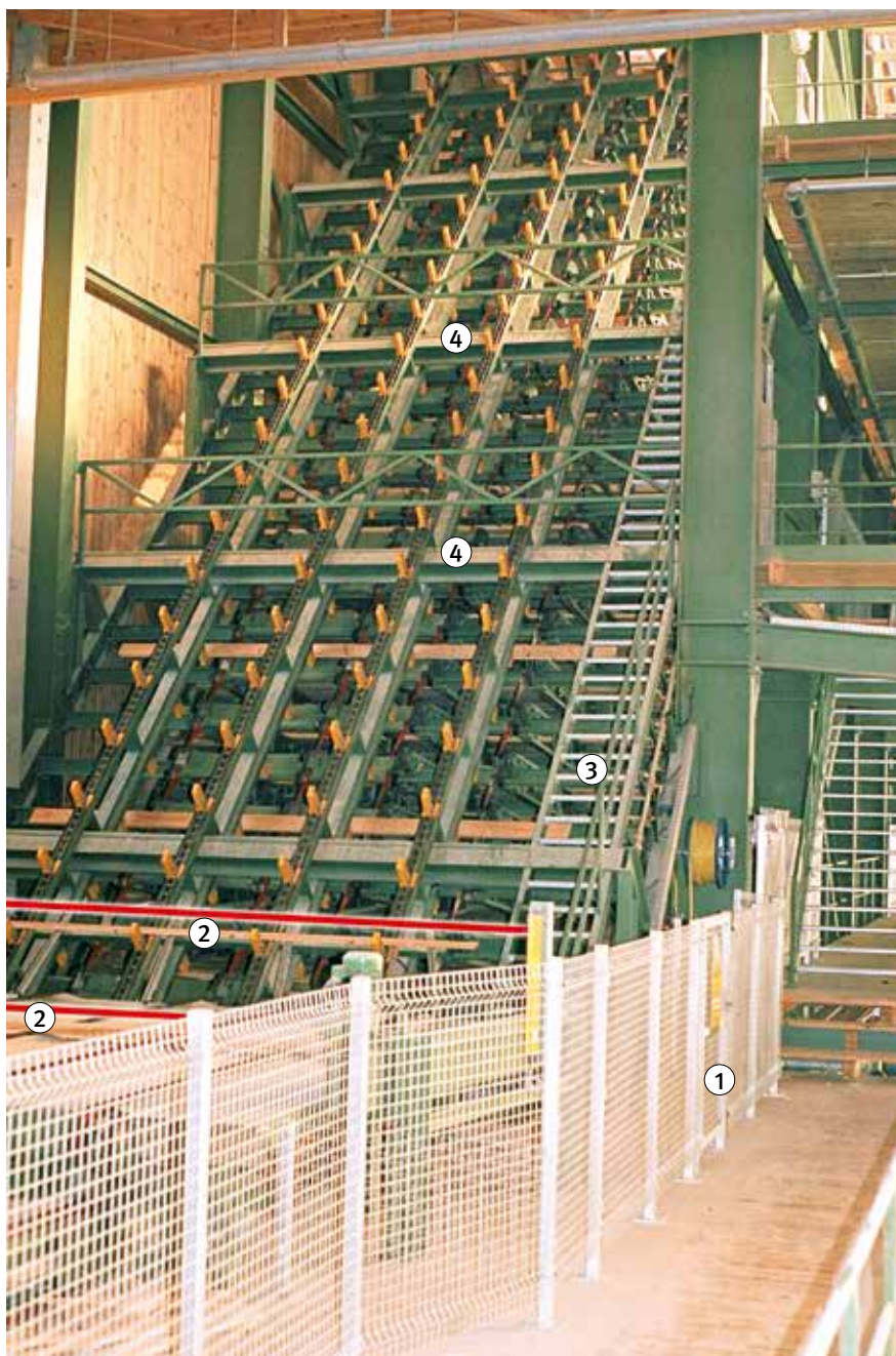
Bild 20: Sortierförderer einer Horizontal-Etagen-Sortieranlage
