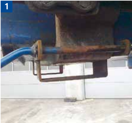
Arbeitsbühne gegen Abkippen und Abrutschen formschlüssig sichern (Steckbolzen mit Splint gesichert).
