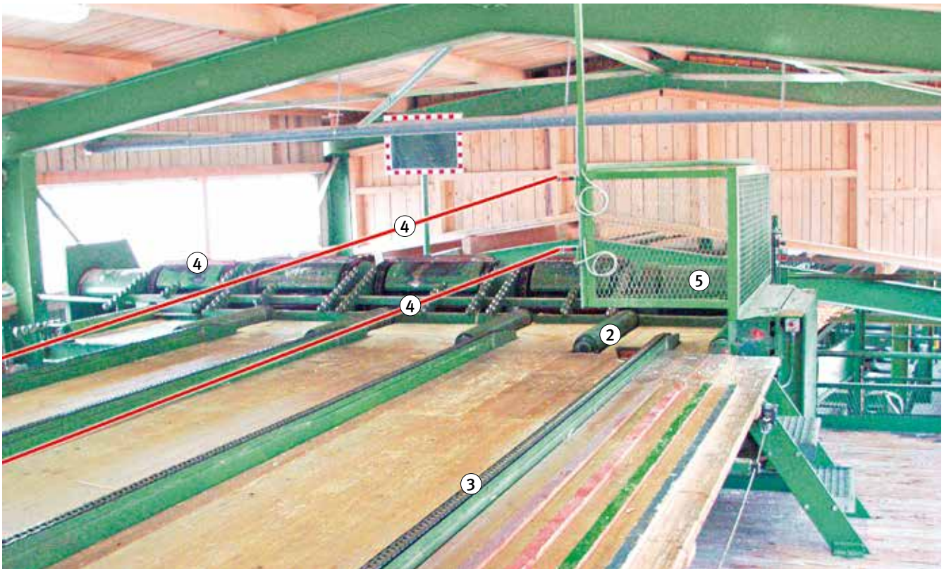
Bild 12: Anlagenbereich Obere Beurteilung
