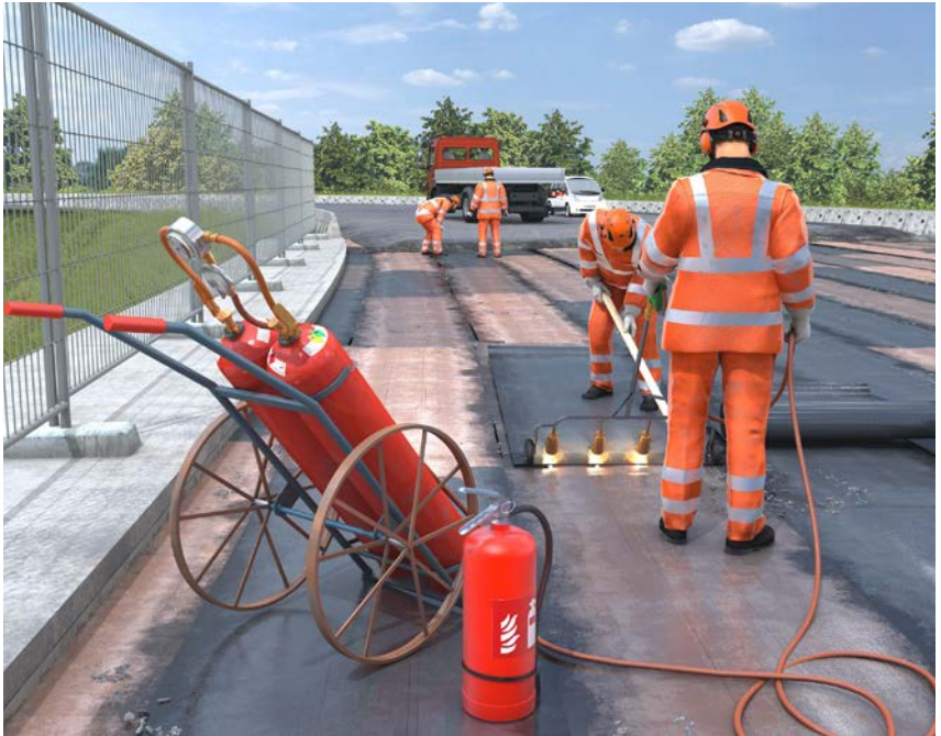
Abb. 6 Arbeiten mit Handbrennern
