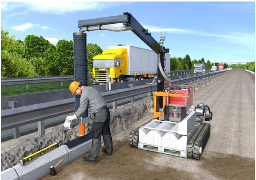
Abb. 7 Bordsteinversetzgerät
