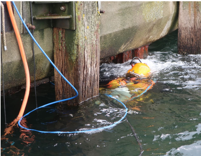
Hand-Arm-Vibration: Taucher bei der Sanierung des Hafenbeckens
