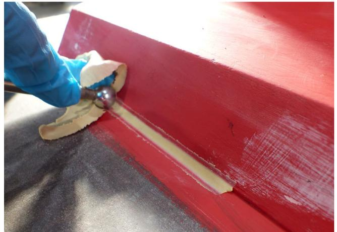
Abb. 12.3 Ziehen einer Hohlkehle mit einem Kugelstab nach Auftrag von Hohlkehlenkitt
