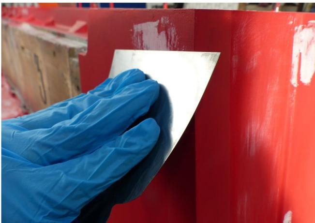
**Abb. 12.4** Auftrag von Spachtelmasse auf eine Oberfläche mit einem Spachtel
