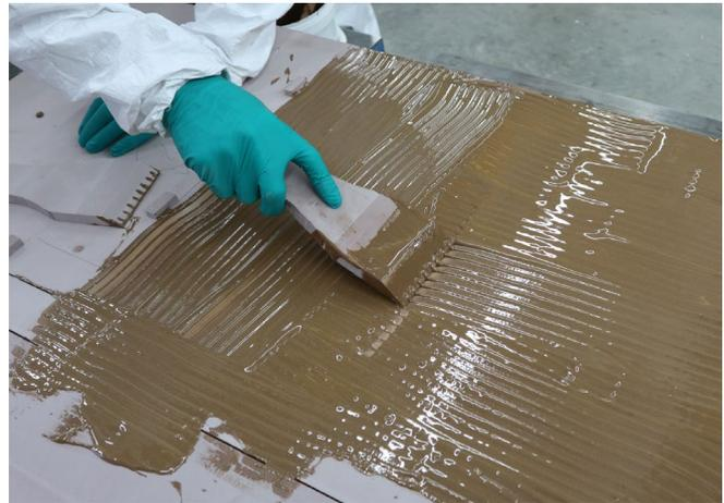
Abb. 12.1 Auftrag eines PUR-Zweikomponenten-Klebstoffs mit einem Zahnspachtel
