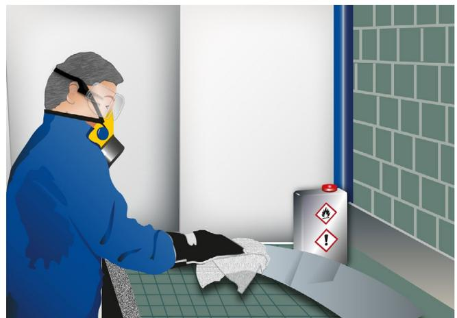
Abb. 12.12 Mitarbeiter mit persönlicher Schutzausrüstung trägt mit einem Lappen Reinigungsmittel auf eine Werkstückoberfläche auf
