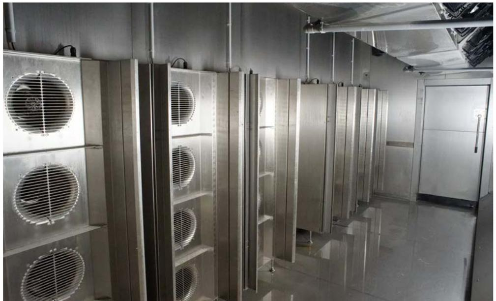
**Abb. 39** Begehbare Bereich eines Schockfrosters vor dem Tiefkühlbereich
